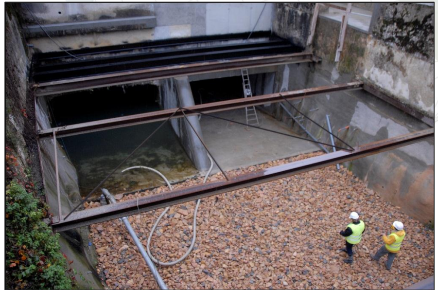
Sortie aspirateur après travaux
