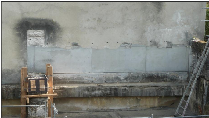
Linteau BA terminé 30/03/11
