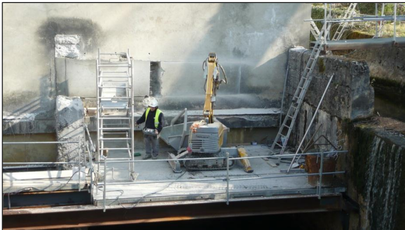
Réalisation du linteau en 3 phases de démolition – bétonnage 23/03/11
