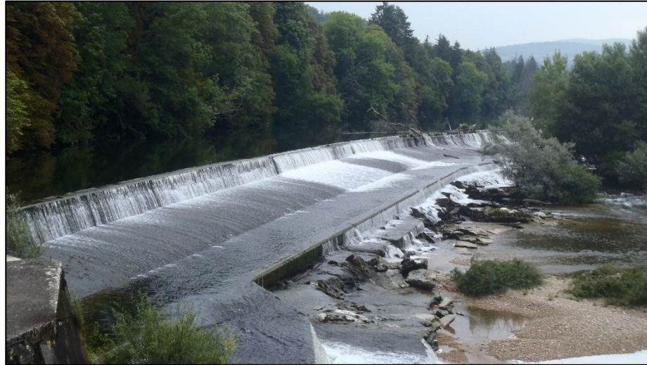
Photographie du barrage (juillet 2011)
