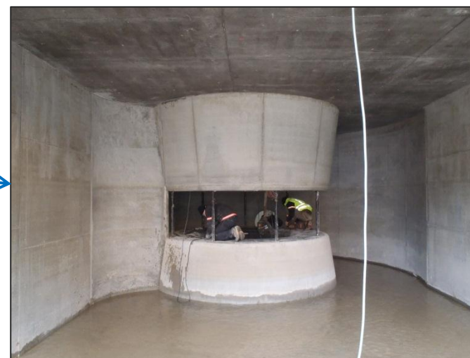
Puits de la turbine terminé 17/01/12
