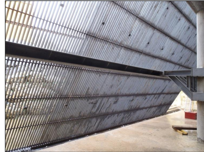
Montage de la grille 17/01/12
