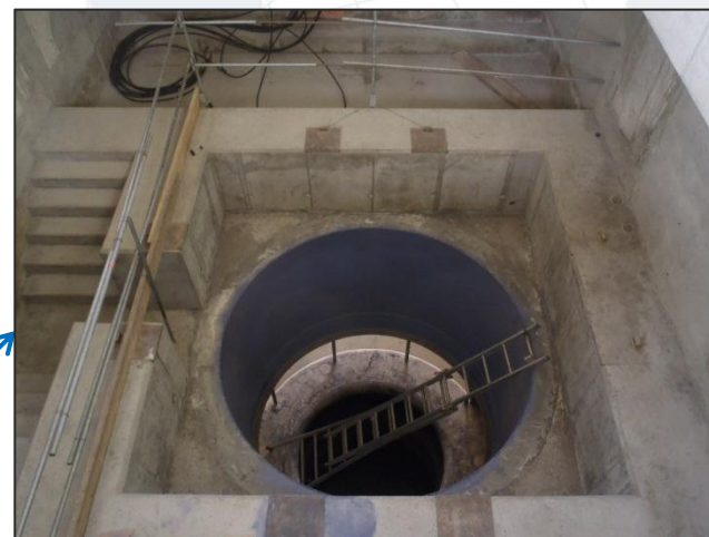
Poutres d'appuis du châssis de l'alternateur 17/01/12
