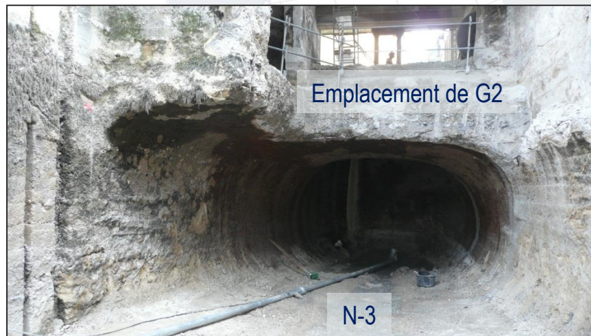
Vue de l'aspirateur d'origine depuis l'aval 11/05/11
