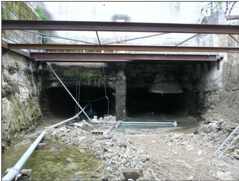
Sortie aspirateur avant travaux
