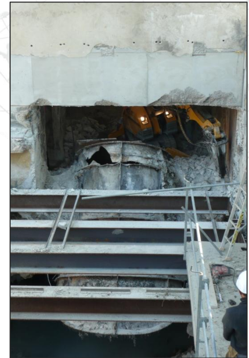
Dépose en cours de G2 05/05/11
