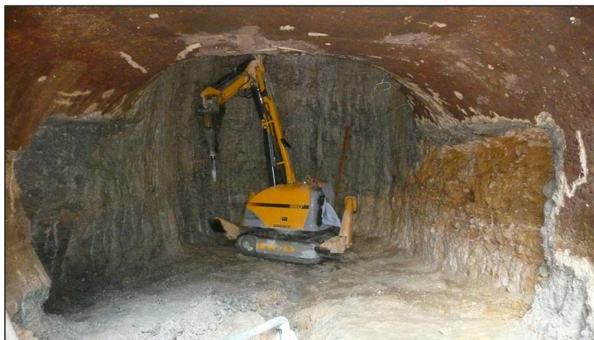
Démolitions dans la partie amont de l'aspirateur 08/06/11
