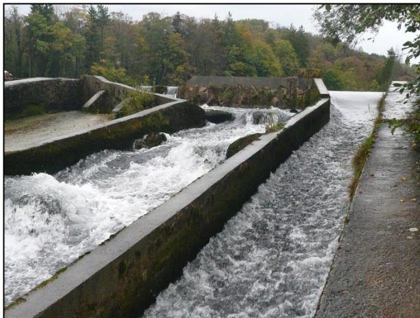
Passe à poissons et passe à canoë en RG du barrage
