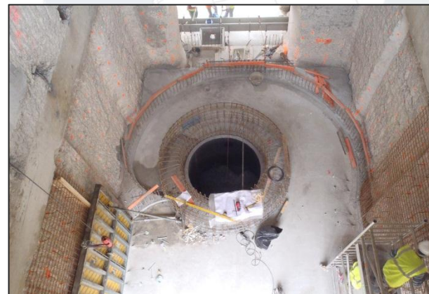
Aspirateur posé et radier bétonné 15/09/11
