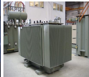
Transformateur Puissance Auxiliaire
