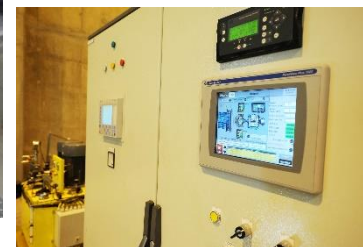
Armoires de contrôle TGBT Historisation Contrôle à distance
