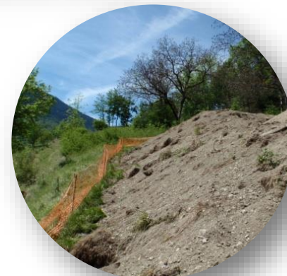
3 – Respect des emprises de chantier
