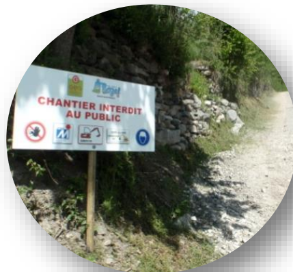
5 – Sécurisation et information sur le chantier
