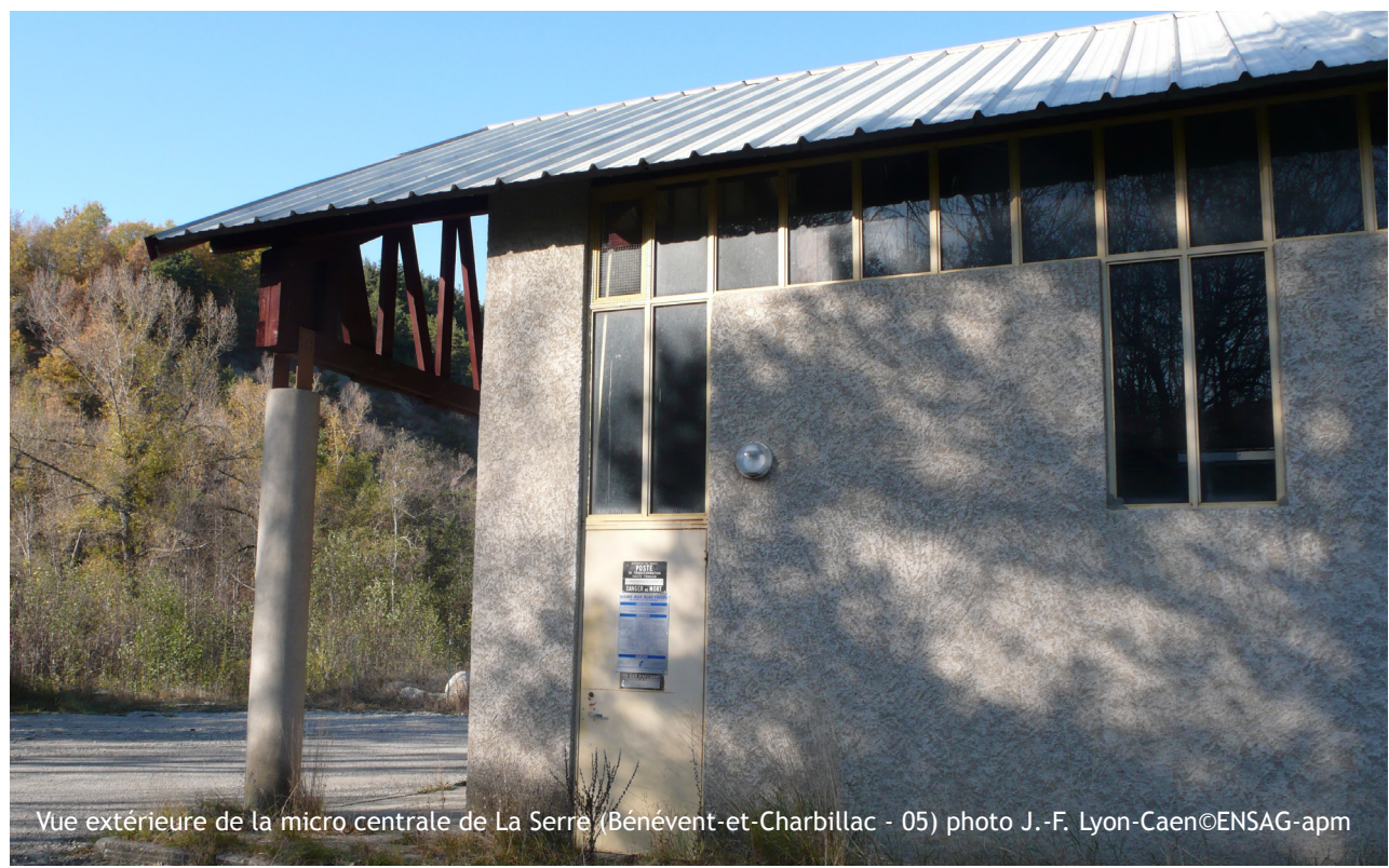
Vue extérieure de la micro centrale de La Serre (Bénévent-et-Charbillac - 05) photo J.-F. Lyon-Caen©ENSAG-apm
