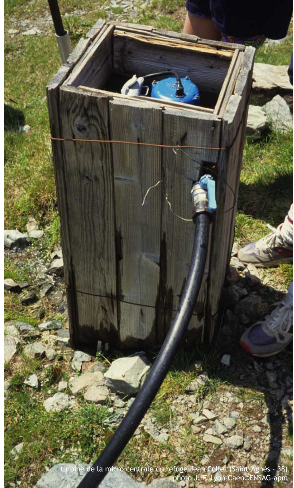
turbine de la micro centrale du refuge Jean Collet (Saint-Agnès - 38) photo J.-F. Lyon-Caen©ENSAG-apm
